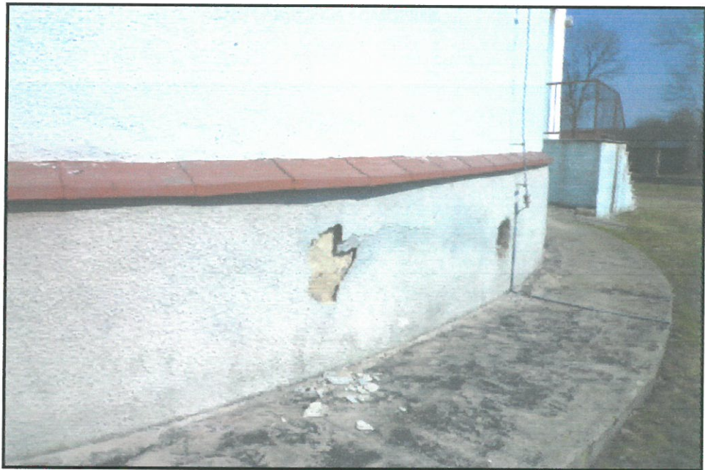
COKÓŁ PRZY BUDYNKU OD STRONY PREZBITERIUM
