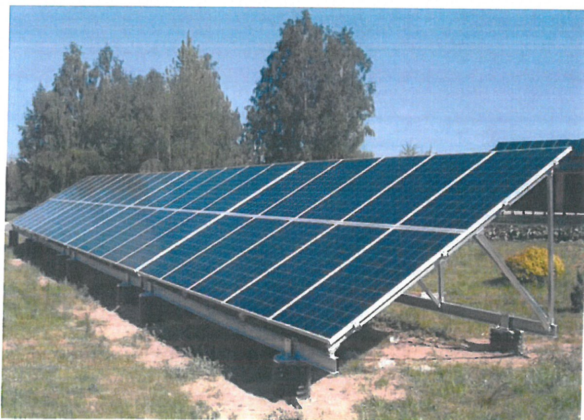
Przykład montażu paneli wolnostojących na gruncie.
